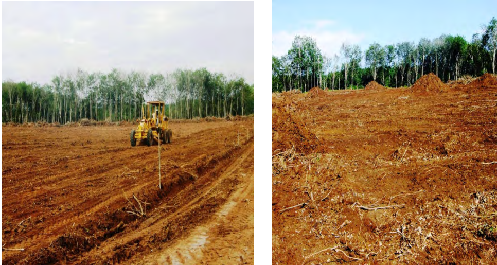
Gambar 1. Perataan area dengan Road Greder
